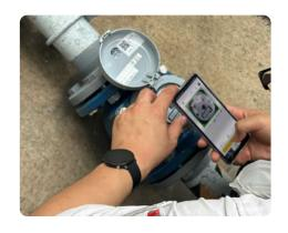
メーターの誤検針や期限切れなどの検針作業の精度向上策とし て、三菱地所ITソリューションズが開発した「楽杉けんしん」を導入 することで、スマホで撮影したメーター画像をAIカメラで分析して 数値を読み取ることができ、正確かつアナログ表示の読み取りも実 現し、直読検針を行う中小規模ビルで有効活用しています。ビルの 特性やコンディションに合わせてシステム構築を行いながら、現在 はオフィス・商業施設への導入しています。
